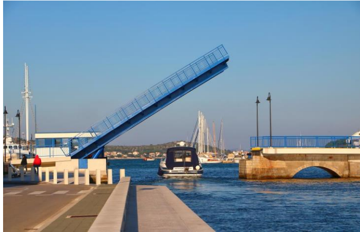
Slika 30.: Rasklopni most u Tisnom [26]
