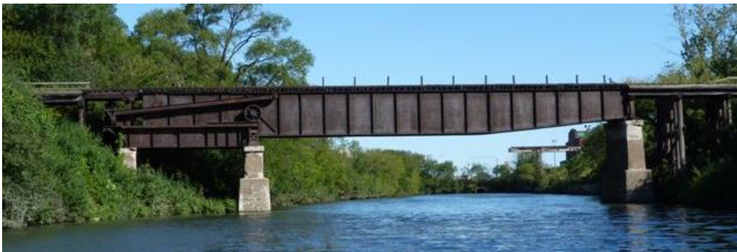
Slika 17.: Zapadni željeznički most, Chicago [15]
