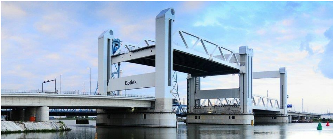
Slika 6.: Botlek most, Rotterdam [10]
