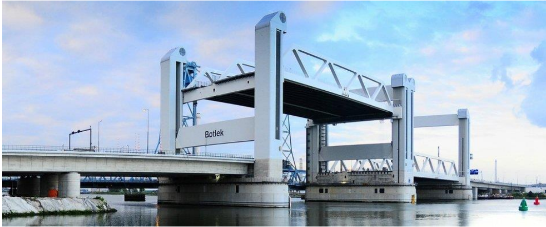
Slika 6.: Botlek most, Rotterdam [10]
