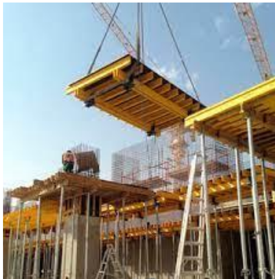
Slika 45: Transport oplata (Izvor [44.])
