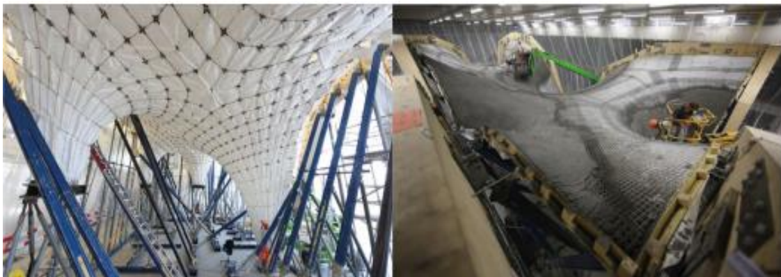
Slika 19: Oplata od tekstila (Izvor [21.])
