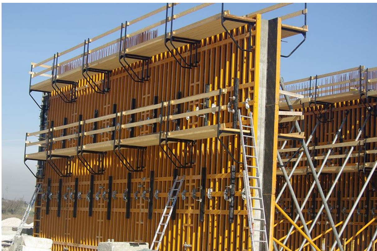
Slika 49: Primjer čeline oplata zida (Izvor [47.]
