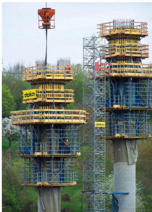
Slika 5: Klizna oplata (Izvor [5.])
