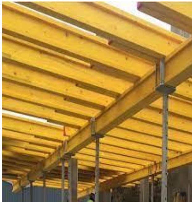
Slika 41: Potkonstrukcija od drvenih greda (Izvor [41].)
