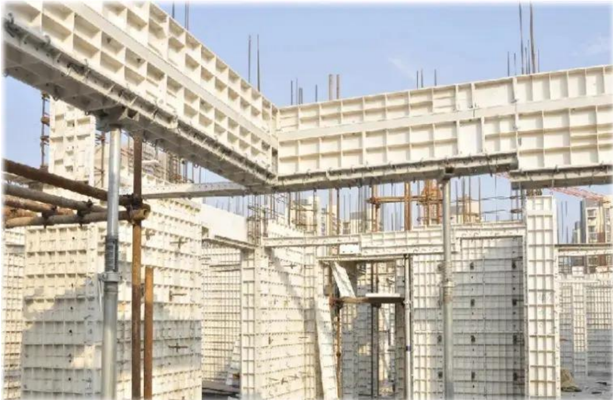
Slika 18: Modularna plastična oplata (Izvor [20.])
