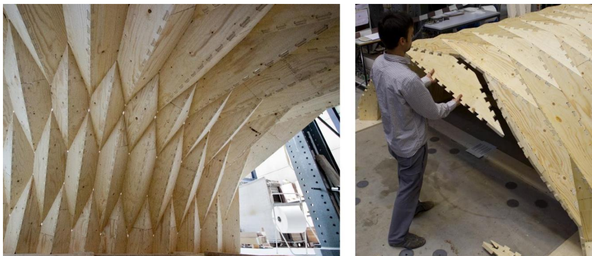
Slika 25: Oplata izrađena CNC mašinom (Izvor [22.])
