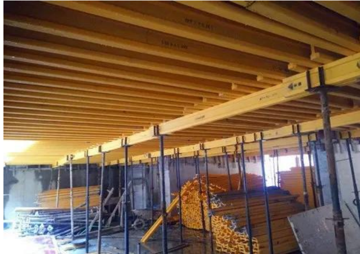
Slika 42: Nosiva konstrukcija oplate od drvenih greda (Izvor [39..])
