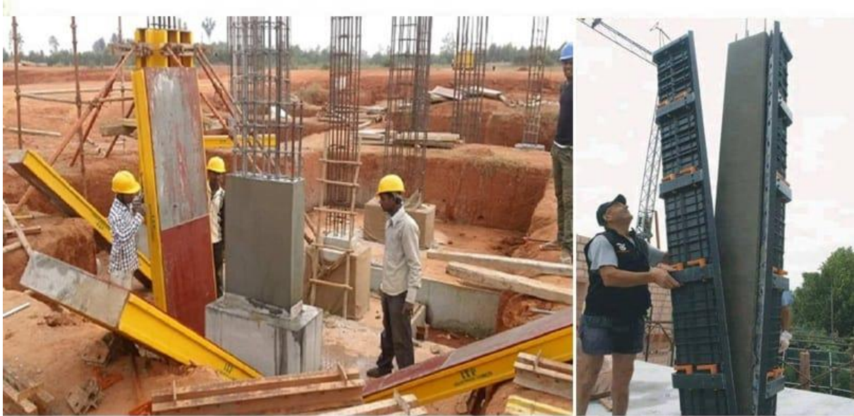
Slika 46: Demontaža oplate stupova (Izvor [44.])
