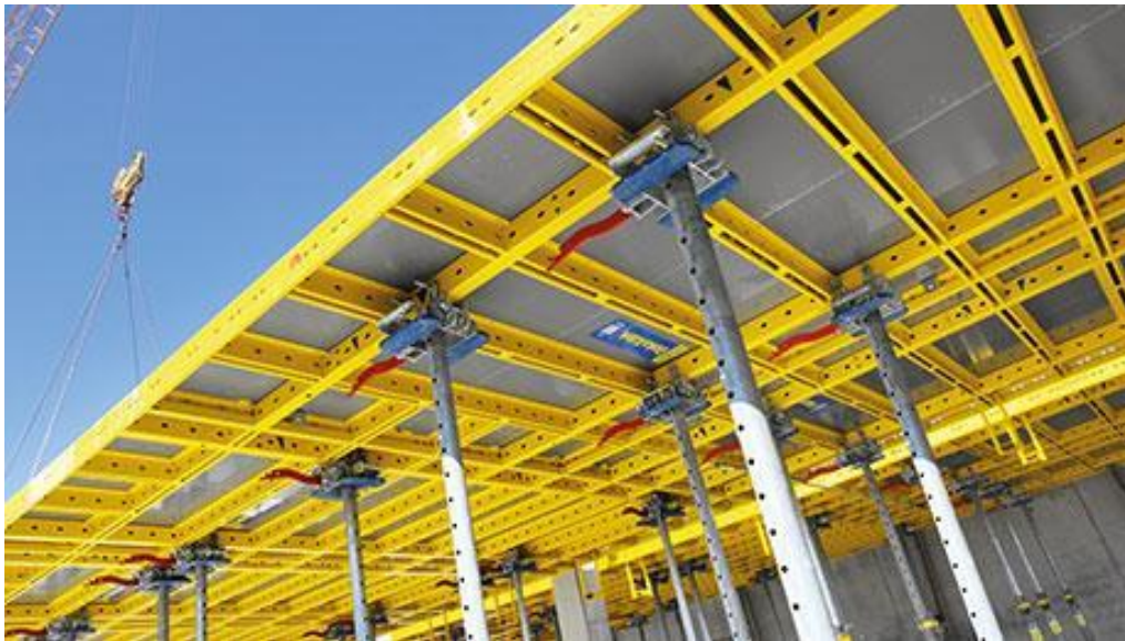
Slika 44: Čelični podupirači (Izvor [43.]
