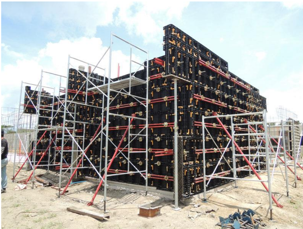
Slika 32: Plastična modularna oplata (Izvor [28.])
