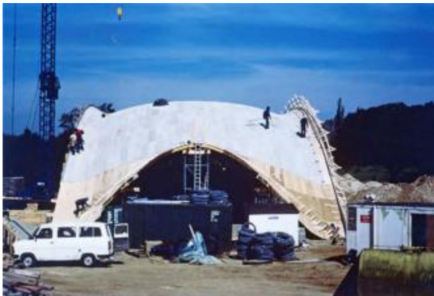
Slika 8: Izgradnja teniske hale (Izvor [8.]
