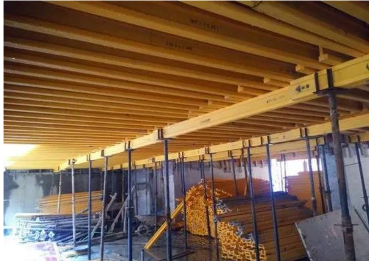
Slika 42: Nosiva konstrukcija oplate od drvenih greda (Izvor [39..])
