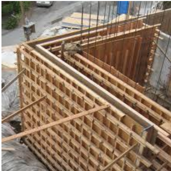
Slika 10: Drvena oplata zida (Izvor [10.])
