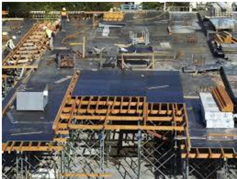
Slika 12: Oplatna ploha od šperploče (Izvor [14.]
