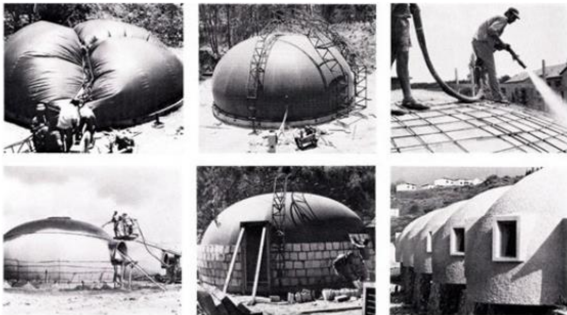
Slika 22: Metoda napinjanja pomoću zraka (Izvor [21.]
