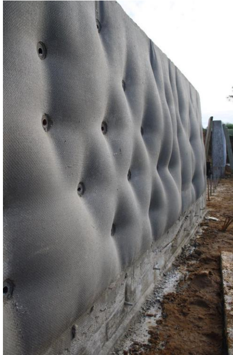
Slika 20: Zid oblikovan platnenom oplatom (Izvor [21.])
