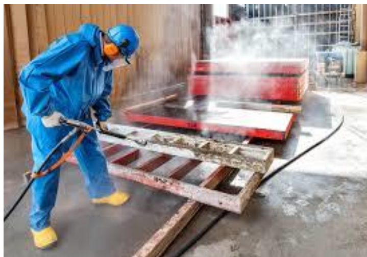
Slika 47: Čišćenje oplate (Izvor [45.])
