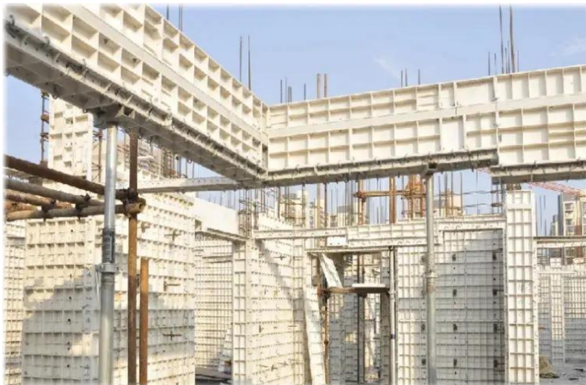
Slika 18: Modularna plastična oplata (Izvor [20.]
