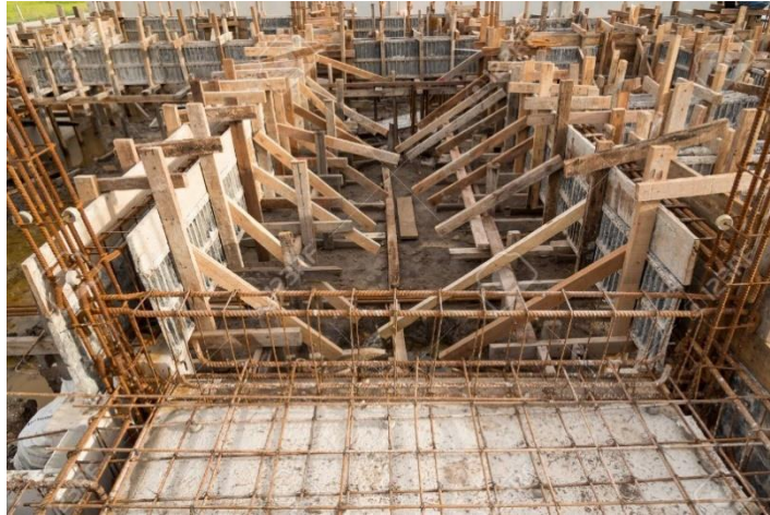
Slika 9: Drvena oplata trakastih temelja (Izvor [9.])
