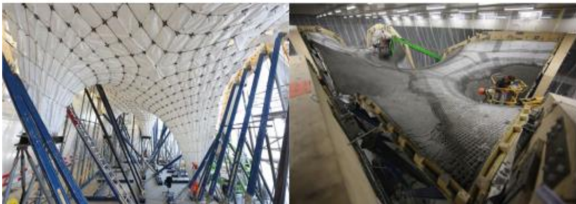
Slika 19: Oplata od tekstila (Izvor [21.])
