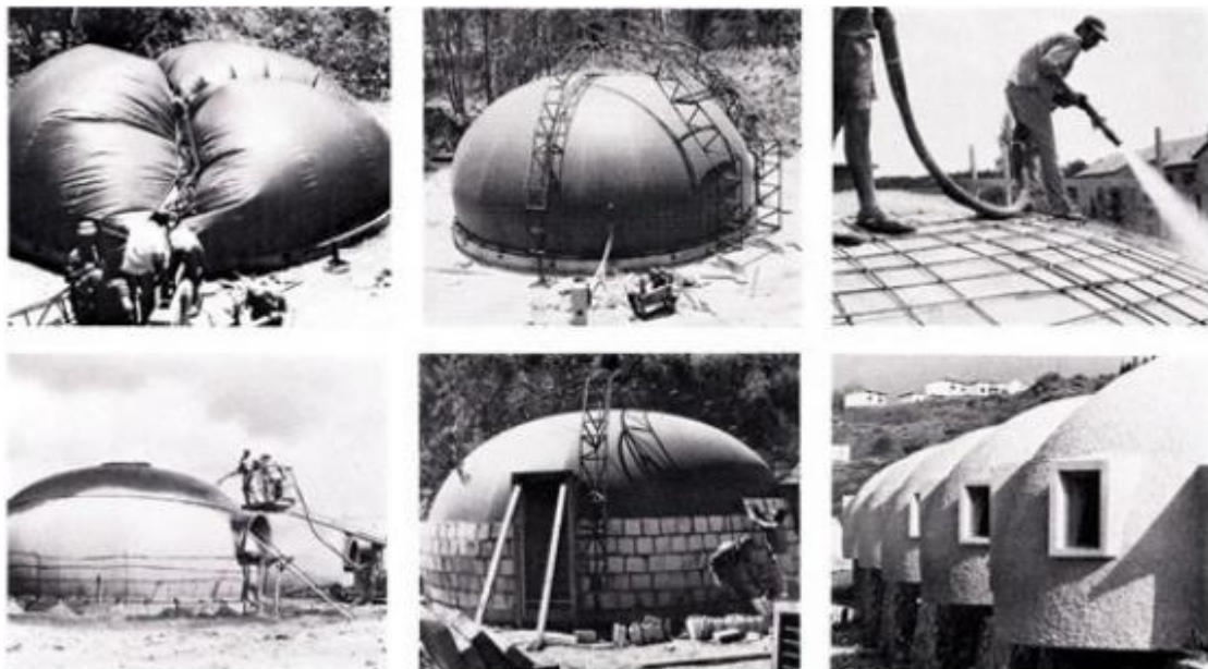
Slika 22: Metoda napinjanja pomoću zraka (Izvor [21.]
