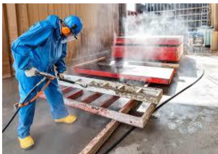
Slika 47: Čišćenje oplate (Izvor [45.])
