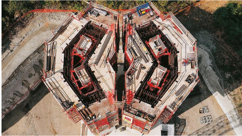
Slika 53: Penjajuća oplata Millau vijadukta (Izvor [50.]
