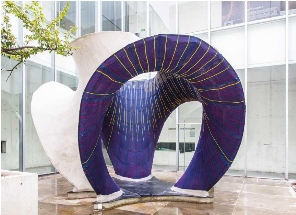
Slika 23: Pletena oplata (Izvor [21.])
