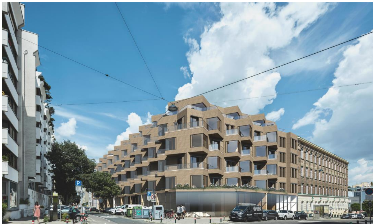
Slika 3.1. Pogled na konstrukciju - sjeverozapad
