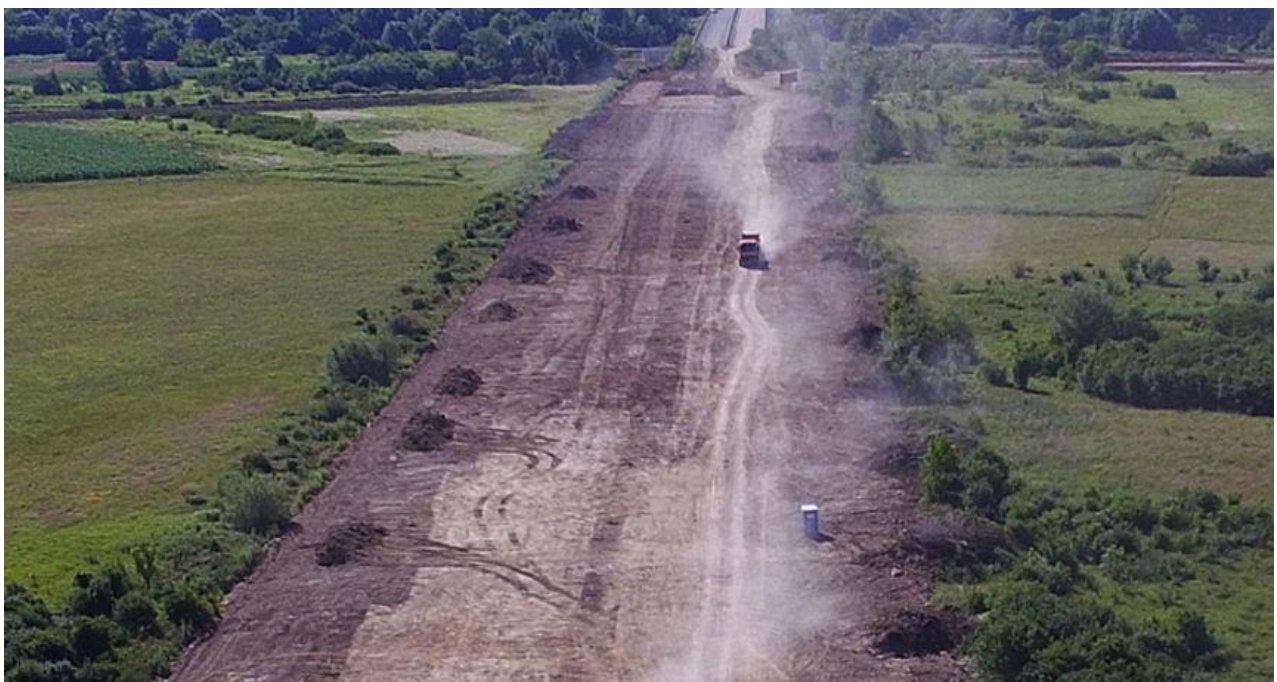
Slika 1.: Masovni zemljani radovi- priprema gradnje vijadukta Sajevac (Izvor: KAportal)
