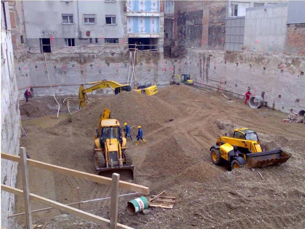
Slika 2.: Standardni zemljani radovi- pripremni radovi gradnje stambenog objekta (GK grupa)
