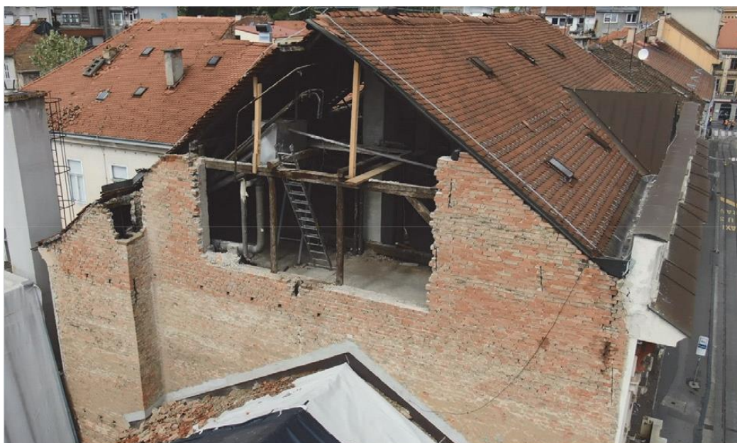
Slika 5: Rušenje zabatnog zida [6]
