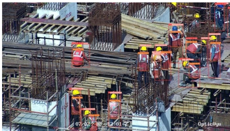
Slika 5: Detekcija zaštitne opreme u stvarnom vremenu primjenom drona u kombinaciji s umjetnom inteligencijom/strojnim učenjem (9)
