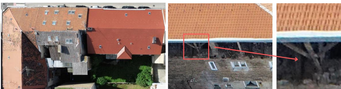
Slika 42. Vidljivi elementi krovne konstrukcije (RGB kamera na dronu)
