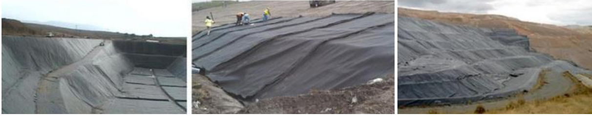
Slika 15.-:Postavljanje geomembrana (Izvor: [4])
