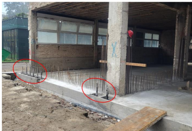
Slika 85.: Izvedena su geotehnička sidra [26]
