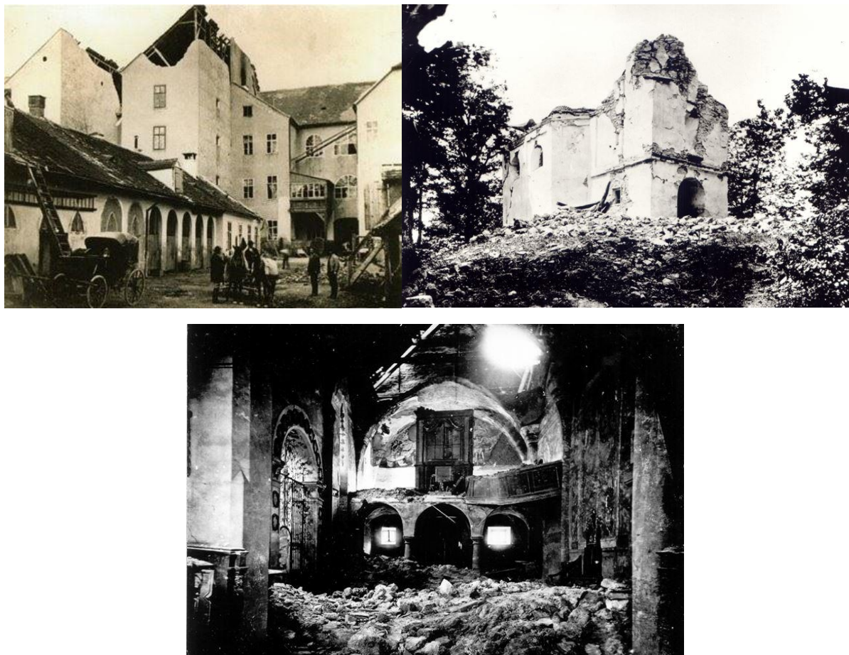
Slika 14.: Oštećenja nastala potresom 1880. Godine u Zagrebu [13]
