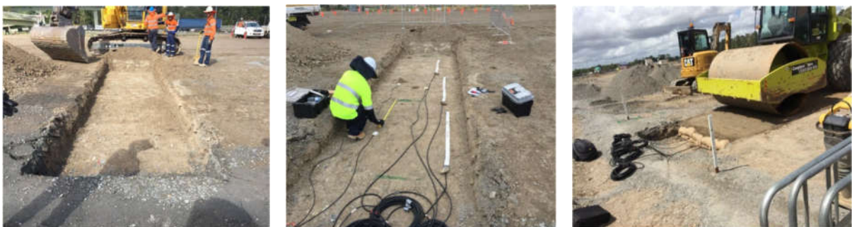
Slika 5-11 Postupak instalacije TDR-a sa sondama s ravnim trakastim kabelom [303]
