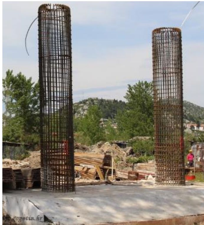
Slika 27. Armirano- betonski piloti
