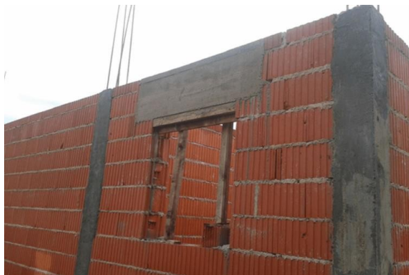
Slika 8: Konstruktivni toplinski most
