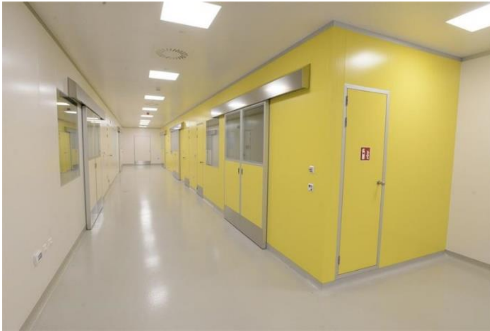
Slika 12. Unutrašnjost čistih prostora u Belupovom pogonu (Klimaoprema, 2022)
