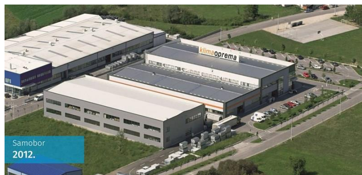
Slika 9. Proizvodni pogon i skladište u Samoboru, 2012. godine (Klimaoprema, 2022)
