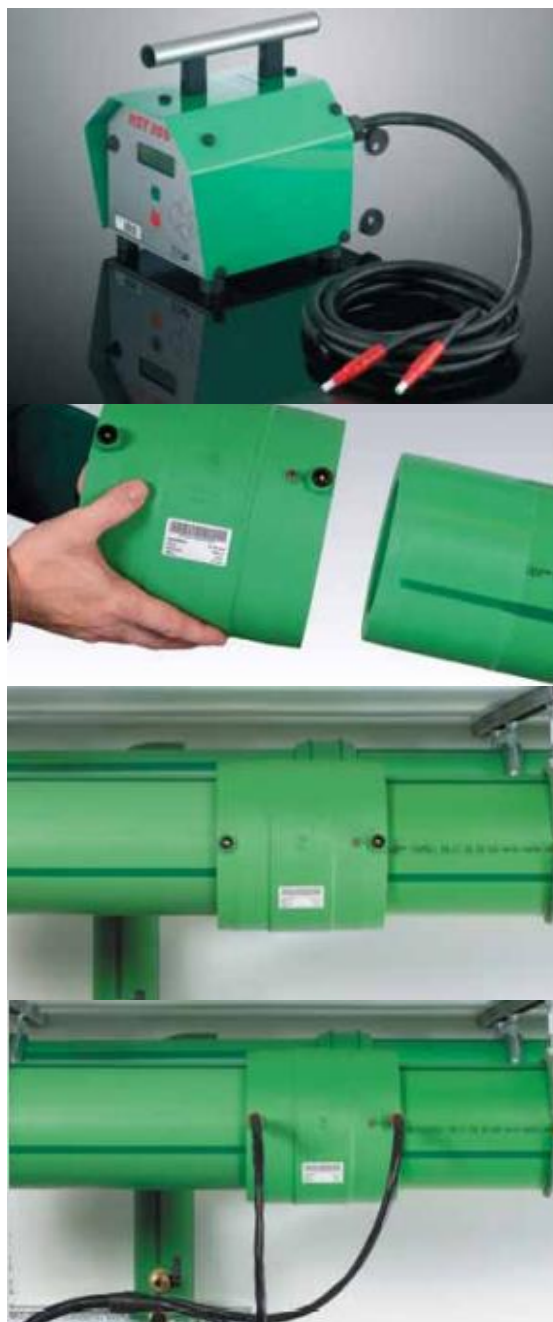
Slika 18. Spajanje spojnica [11]
