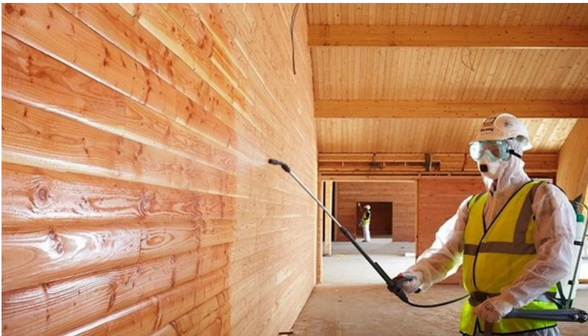
Slika 2.46 Primjena usporivača požara [47]
