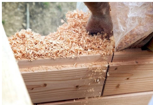
Slika 2.18 Drvene strugotine kao toplinska izolacija
