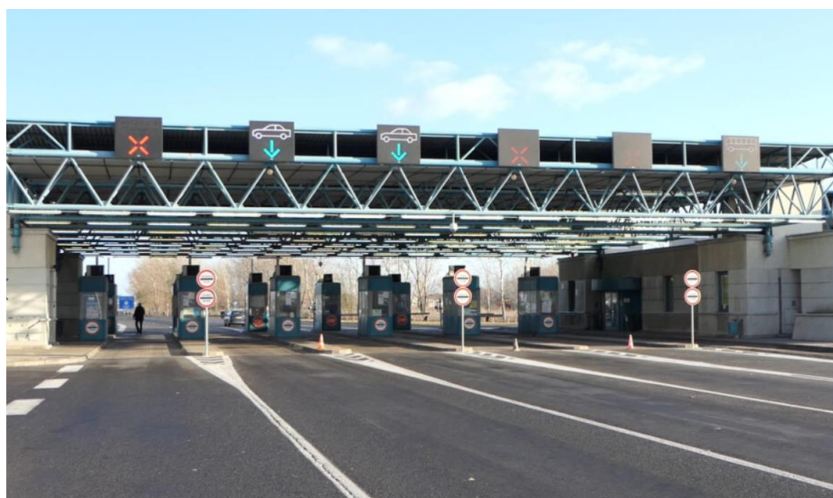
Slika 17. Granični prijelaz Horgoš prije rekonstrukcije (Ministarstvo građevinarstva, saobraća i infrastrukture, 2021)
