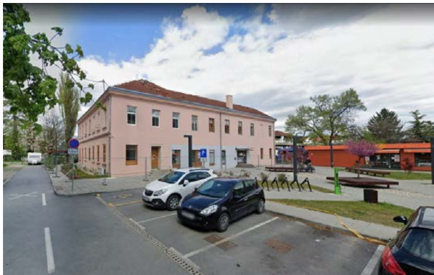
Slika 4 Južna strana objekta
