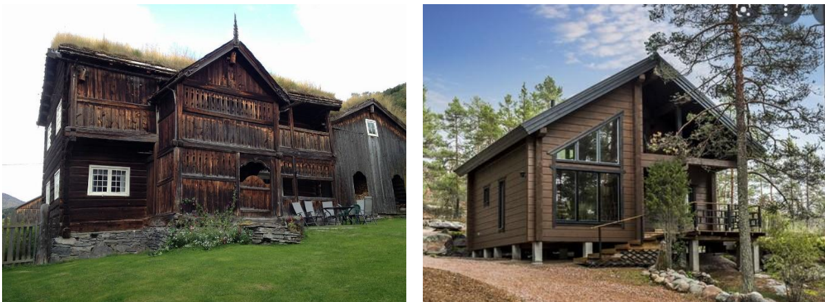
Slika 3. Primjer log – house tipa gradnje drvenih kuća – tradicionalno (lijevo) i suvremeno (desno)
