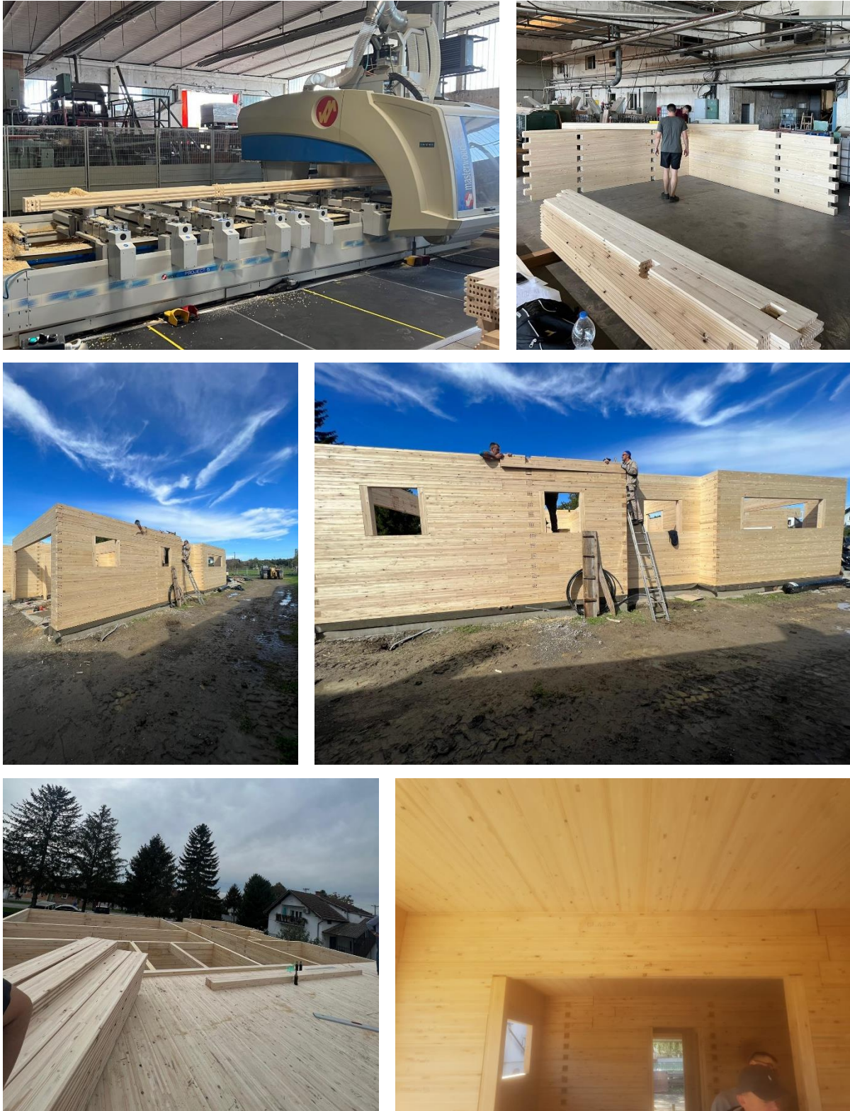
Slika 6. Prikaz proizvodnje (gore) i montaže (sredina i dolje) drvenih prošupljenih elemenata
