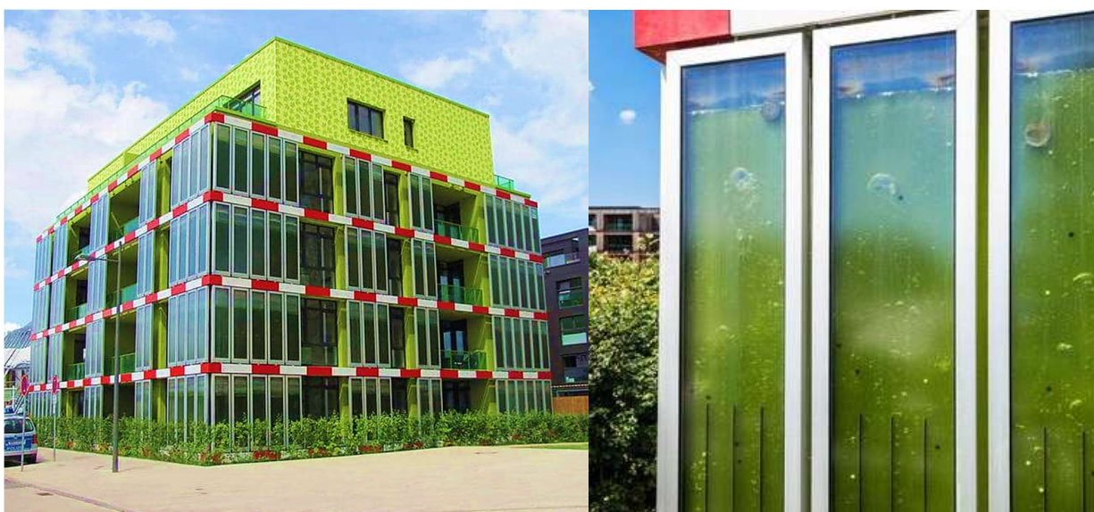
Slika 26. Bioreaktorski paneli postavljeni na stranama zgrade za proizvodnju energije Izvor: The First Algae-Powered Building Presents Unique Renewable Energy Solution | Engineering.com
