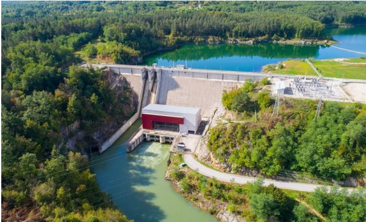
Slika 7. Betonska brana (Betonska brana HE Lešće).
