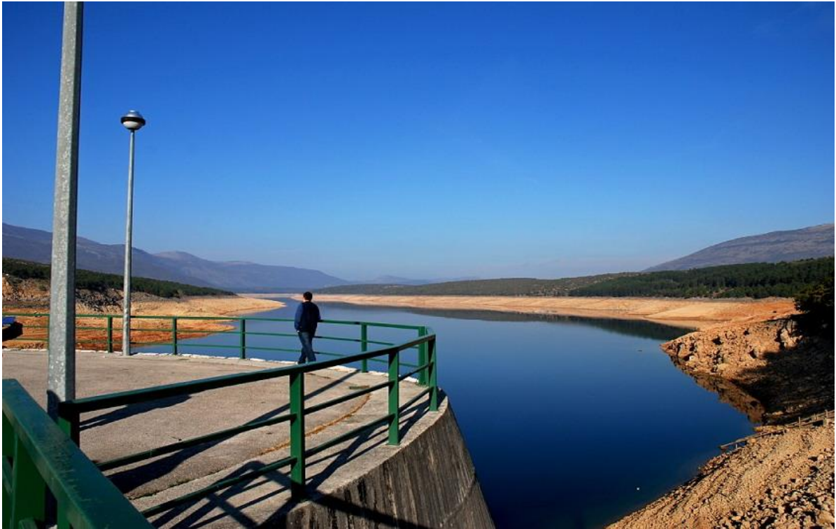
Slika 4. Brana i akumulacijsko jezero HE Peruća.
