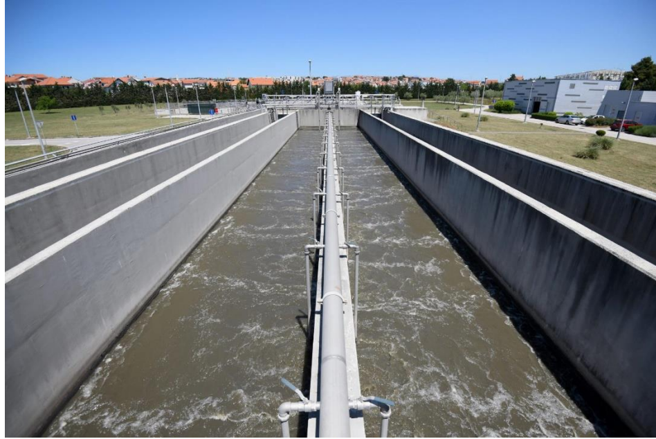
Slika 6 – Pjeskolov na uređaju za pročišćavanje u Zadru
