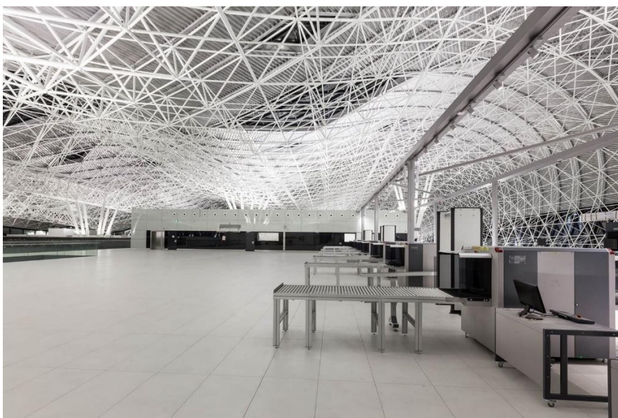
Slika 17. Prostorna čelična rešetka tipa "Mero"
