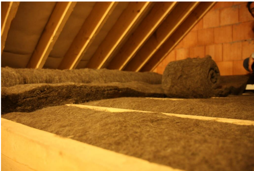
Slika 7. Izvedba izolacije ovčjom vunom
