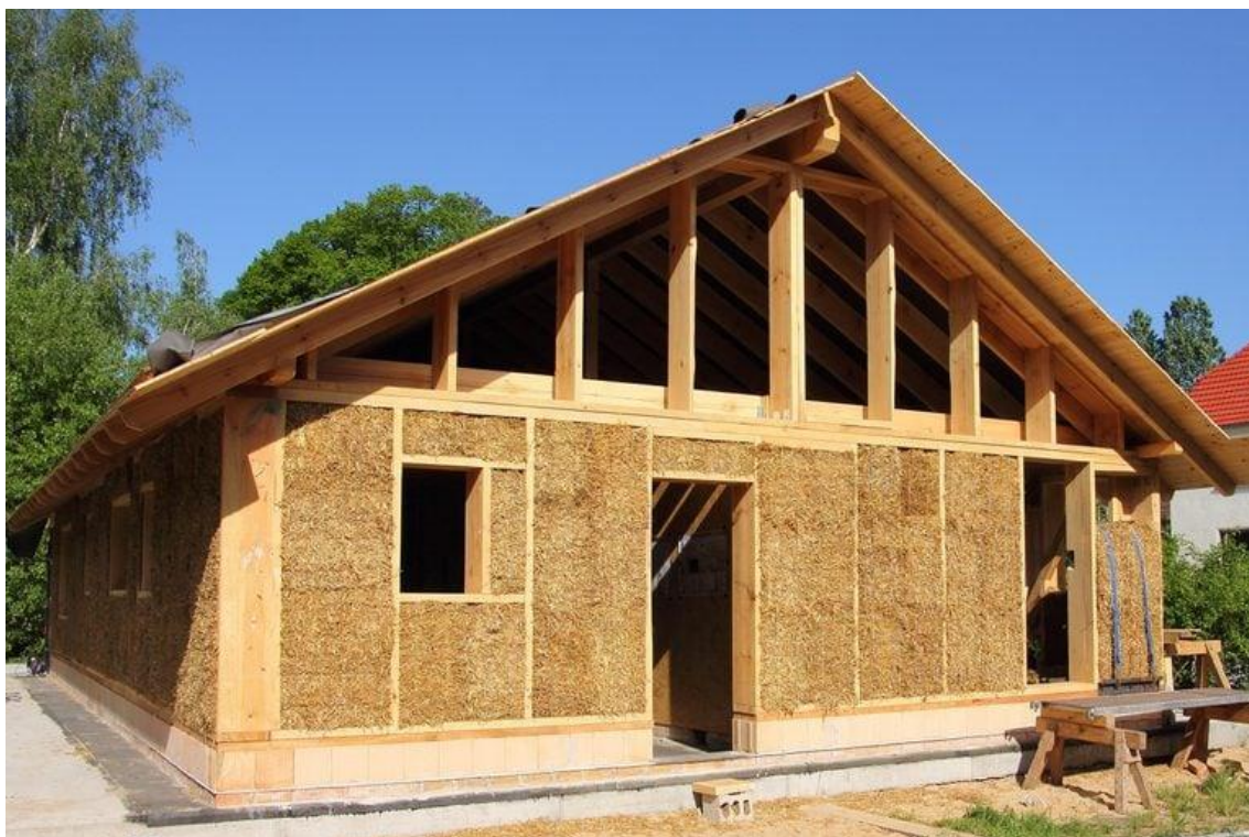
Slika 9. Primjena slame za izolaciju
