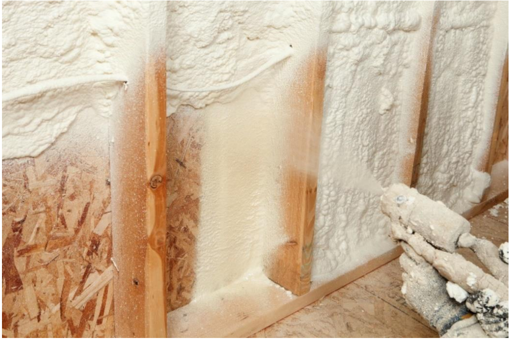
Slika 24. Izvedba izolacije poliuretanskom pjenom
