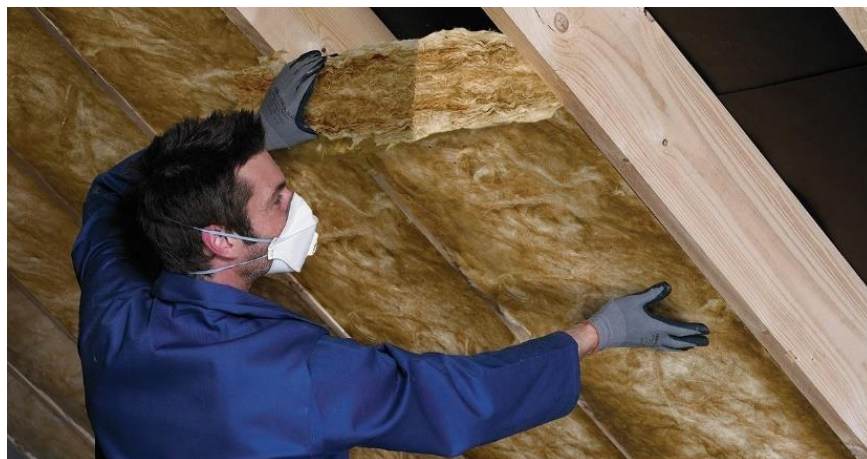
Slika 19. Postavljanje staklene vune
