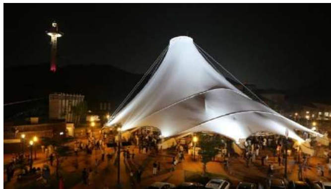
Slika 15. Primjer izvedene konstrukcije stožastog oblika
