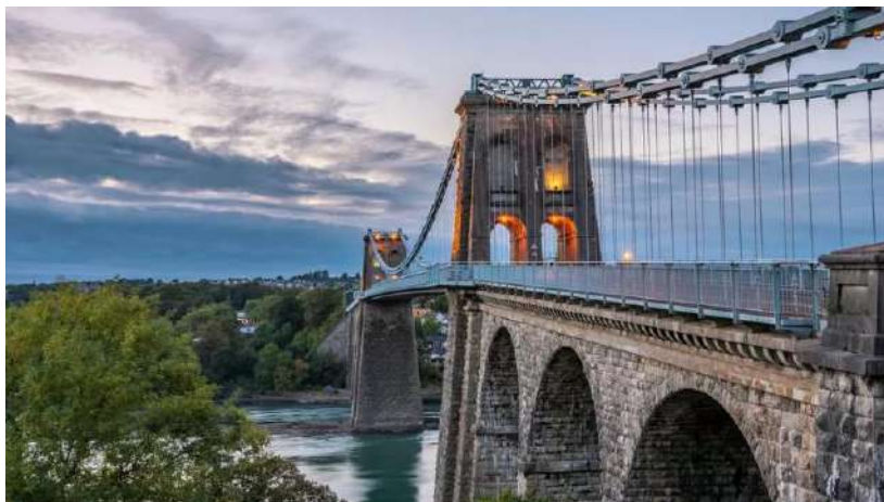
Slika 4. Most Menai, Sjeverni Wales
