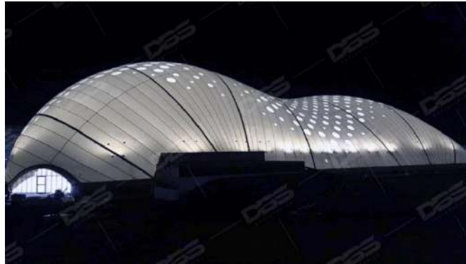
Slika 8. Krovna konstrukcija poduprta zrakom
