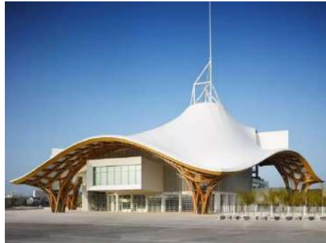
Slika 45. Primjeri konstrukcija s PTFE-om
