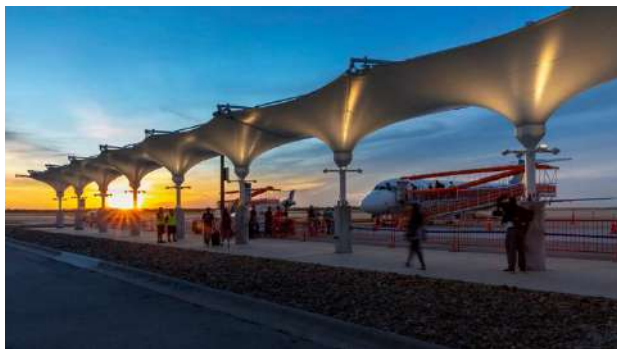
Slika 44. Primjeri konstrukcija od PVC-a
