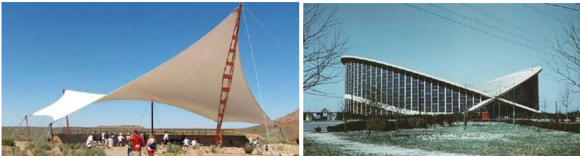
Slika 19. Primjeri izvedenih konstrukcija sedlastog oblika
