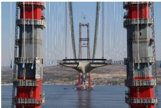
Slika 53. Izvedba kolničke konstrukcije
