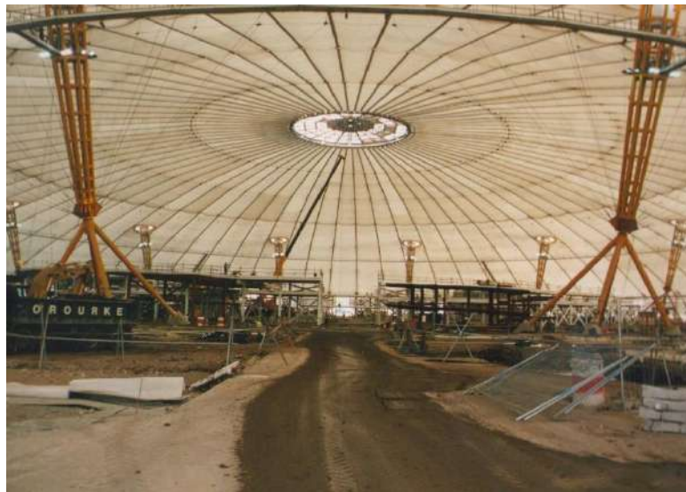
Slika 24. Primjer izvedene konstrukcije s membranskim mrežama
