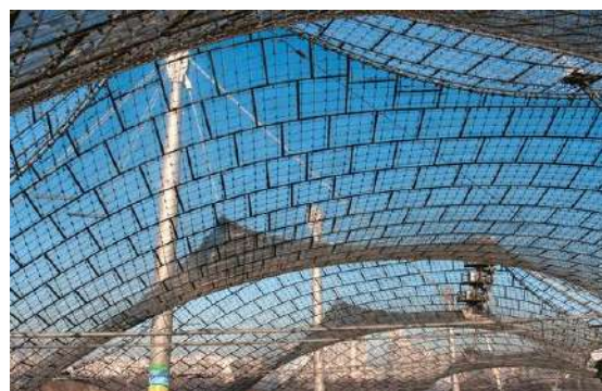
Slika 6. Krovna konstrukcija, Olimpijski stadion
