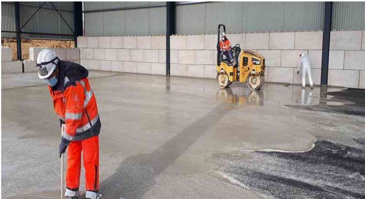
Slika 8. Uklanjanje viška cementnog gela ( https://www.blanloeil.fr/betons/ )
