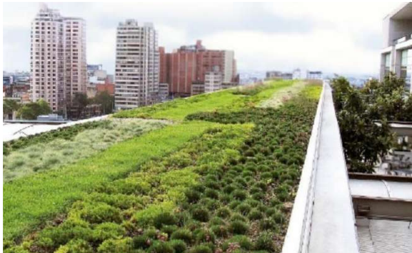
Slika 2. Ekstenzivni zeleni krov [9]
