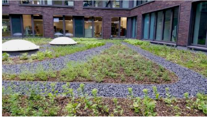
Slika 6. Kombinacija zelenog i plavog krova [14]
