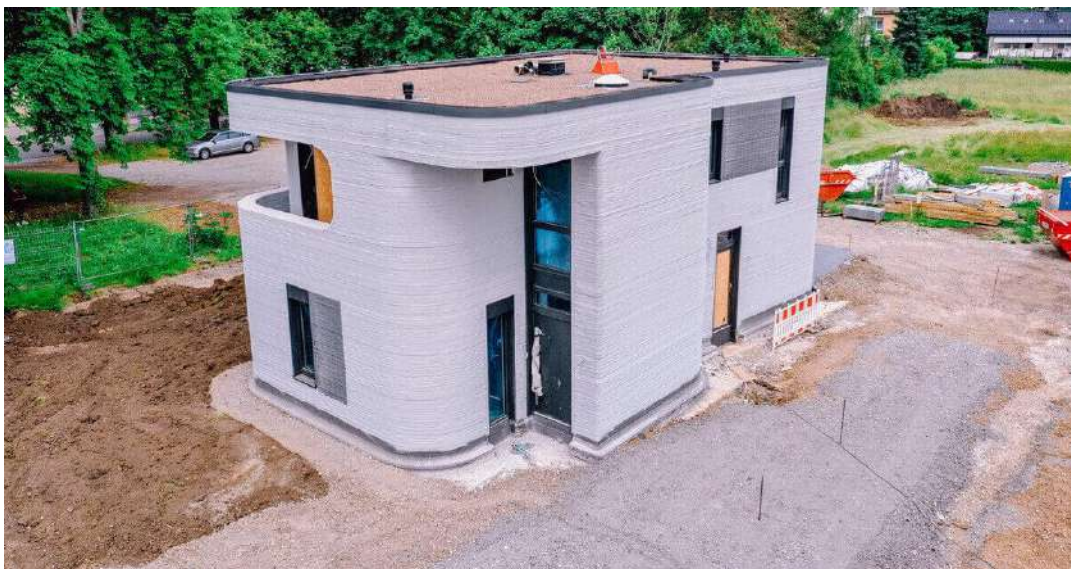
Slika 6 Prva 3D ispisana kuća u Njemačkoj projektirana u AllPlan-u ( https://blog.allplan.com/en/germanys-first-3d-printed-house-is-finished )
