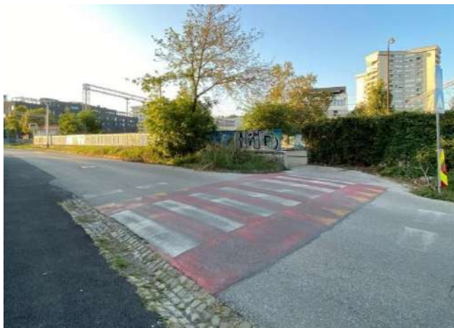
Slika 9 Primjer uzdignute plohe s pješačkim prijelazom na prometnici pokraj ulaza u pothodnik
