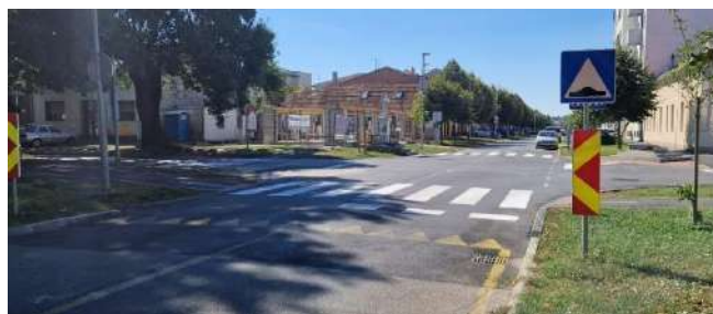
Slika 1 Primjer uzdignutog raskrižja na križanju Rokove i Hebrangove ulice u Osijeku
