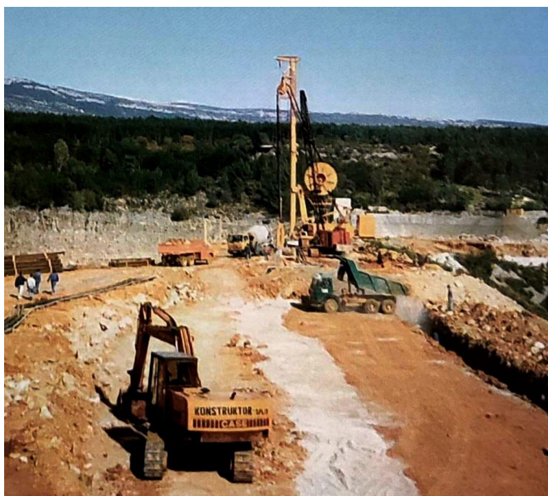
Slika 8 - Radovi na sanaciji desnog boka brane [7].
