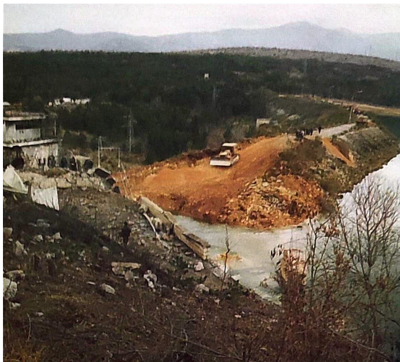
Slika 7 – Krater na lijevom boku brane [7].
