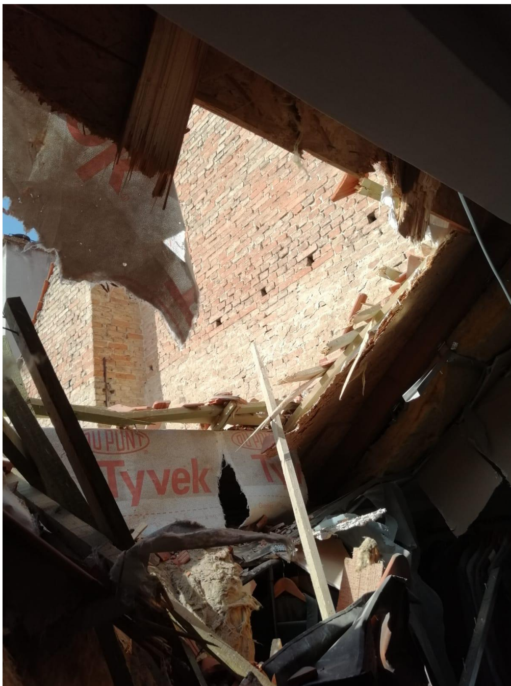
Slika 24 Pogled s unutarnje strane krovišta
