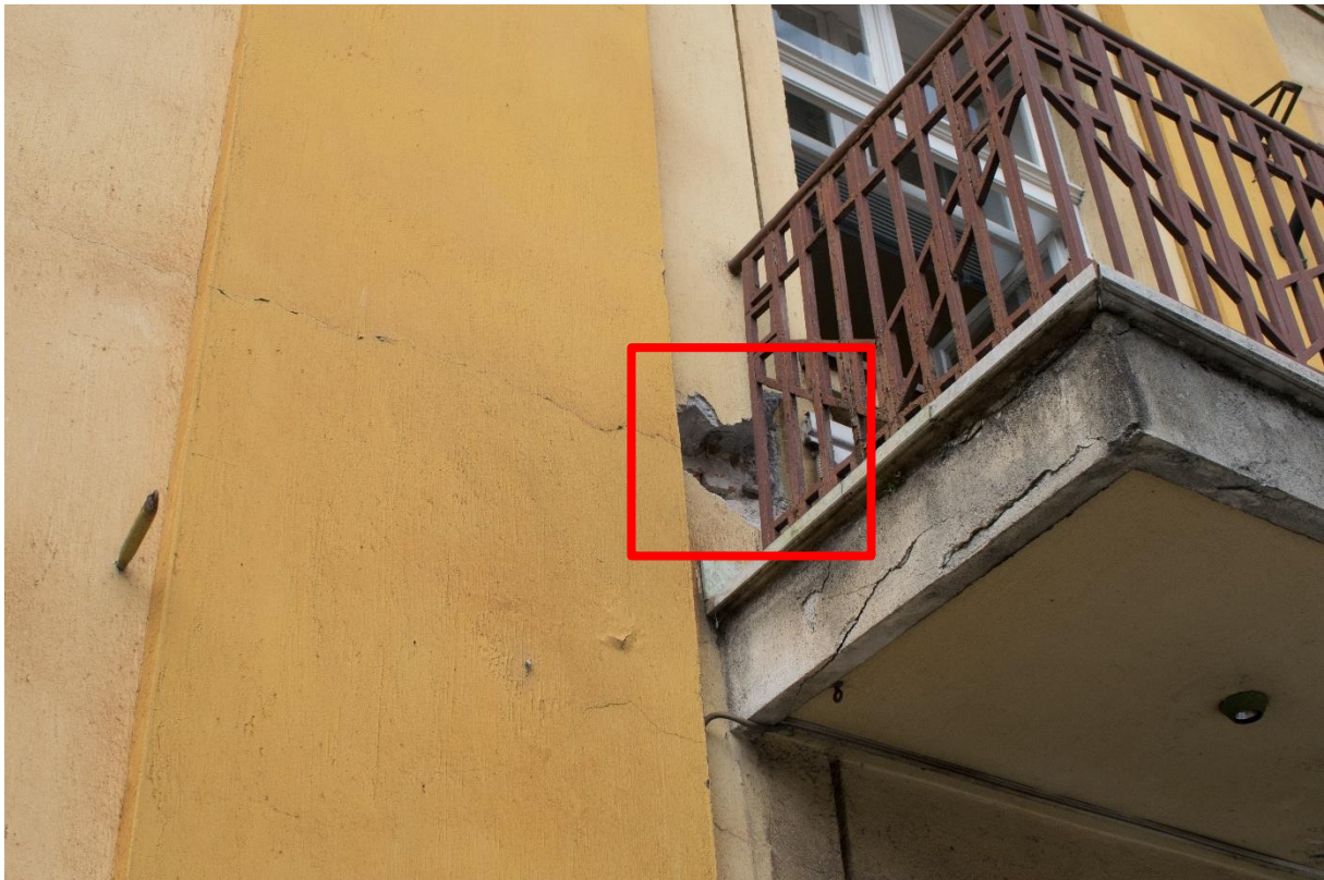
Slika 27 Horizontalna pukotina
