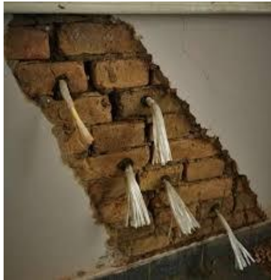
Slika 35 FRP staklena vlakna [10]
