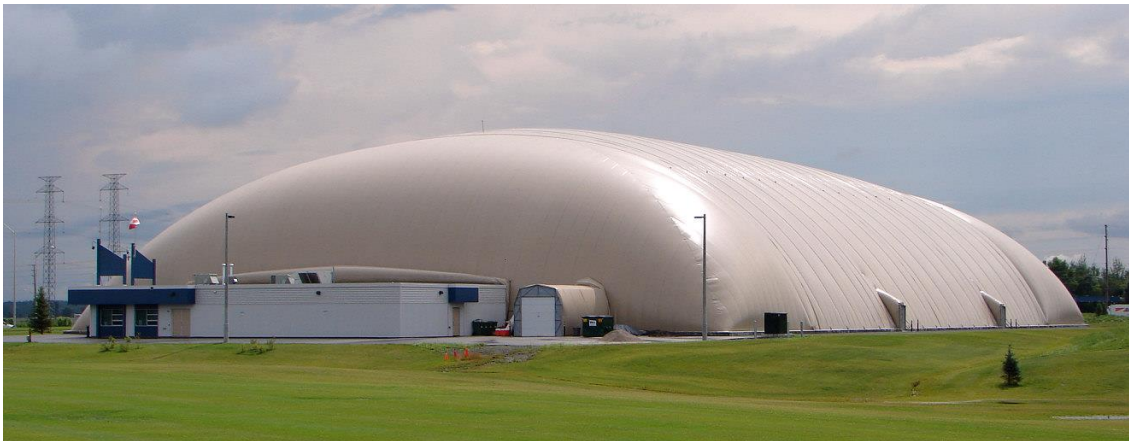
Slika 3. Primjer pneumatske konstrukcije
