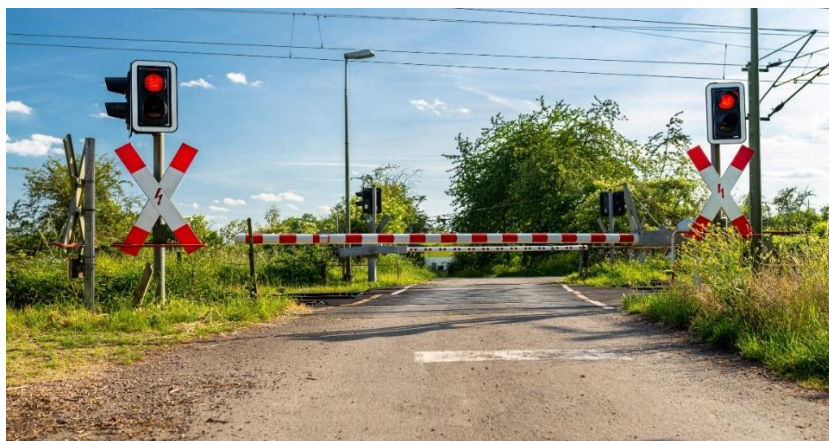
Slika 17. Primjer osiguranja ŽCP-a branicama
