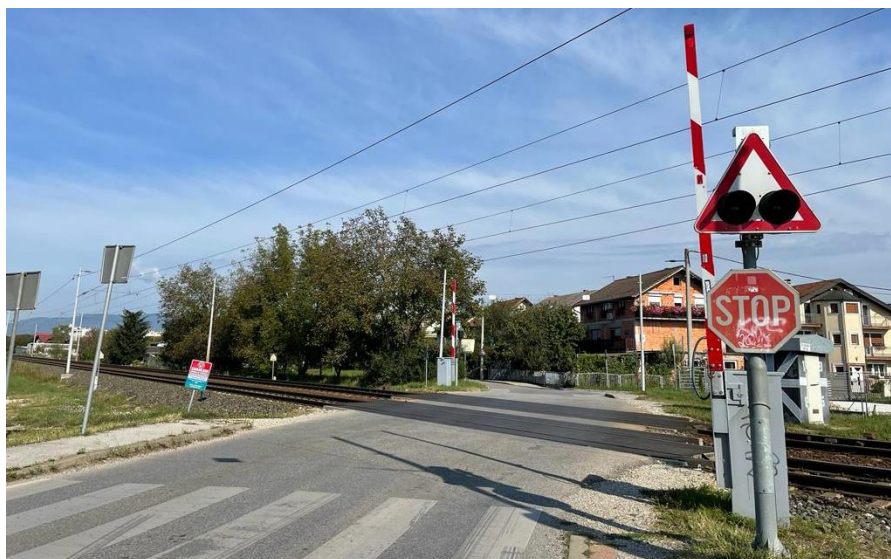
Slika 26. ŽCP Selnička osiguran svjetlosno-zvučnom signalizacijom i polubranicima
