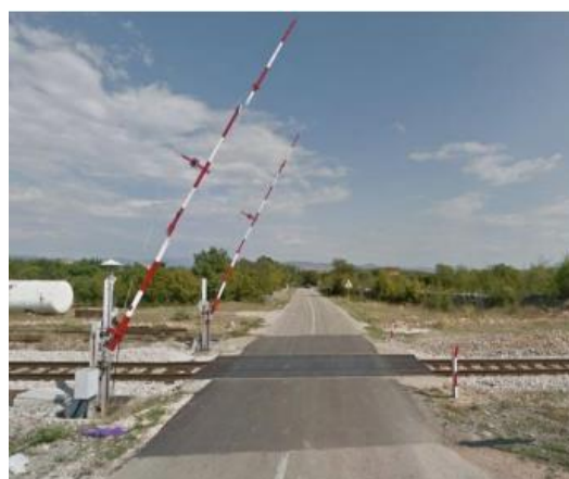
Slika 4. Osiguranje ŽCP-a branikom
