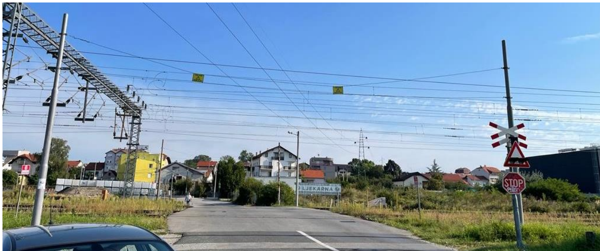
Slika 24. ŽCP Jelkovečka osiguran svjetlosno-zvučnom signalizacijom
