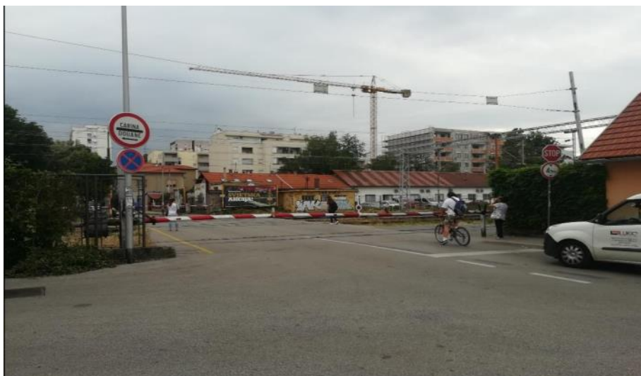
Slika 28. ŽCP Vodovodna osiguran branicima
