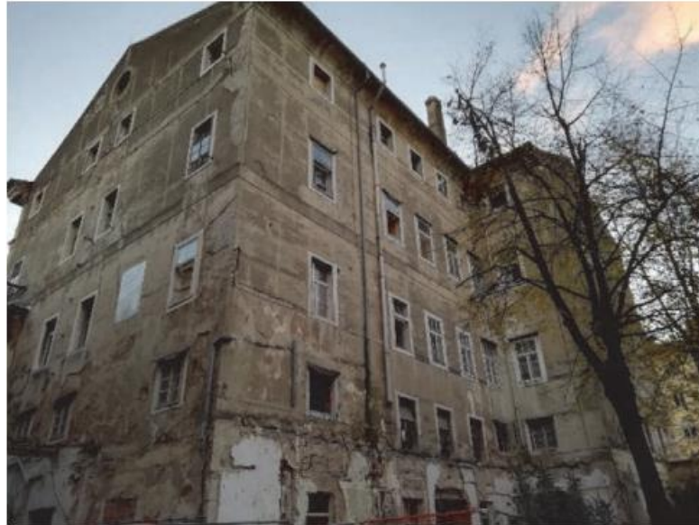
Slika 11. Pročelje Palače Šećerane prije obnove
