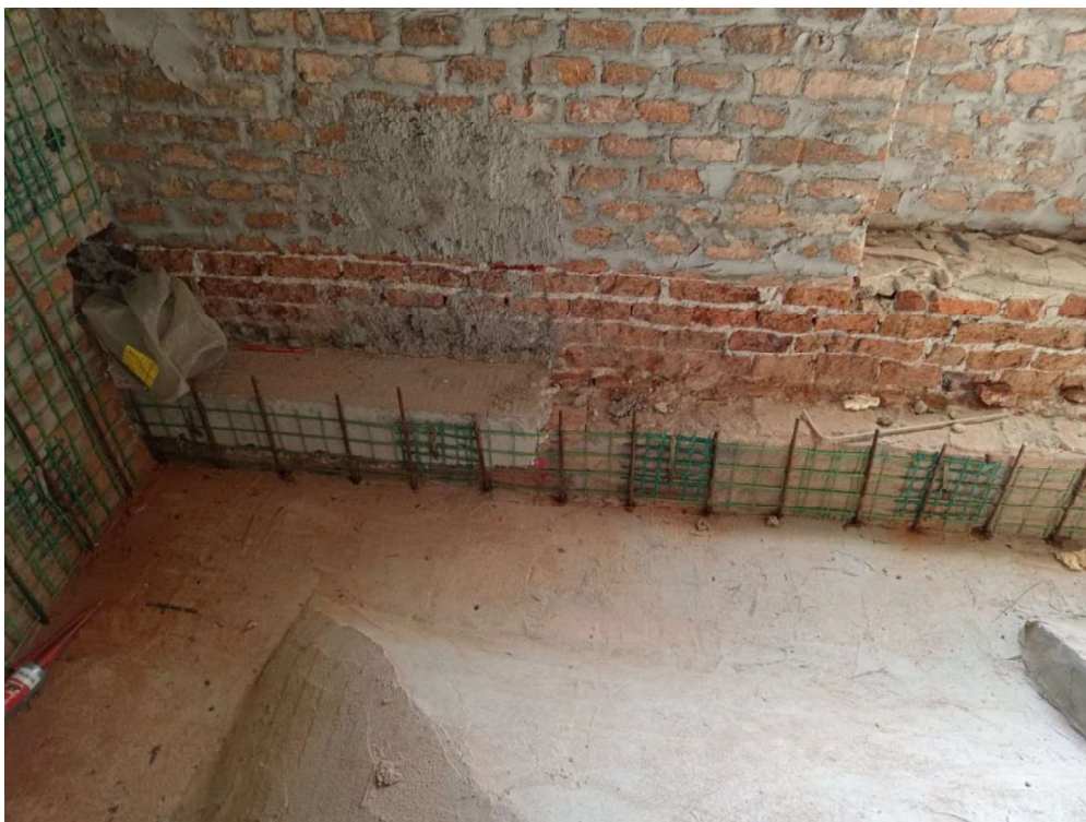
Slika 26 Sidrene šipke za mreže zidova
