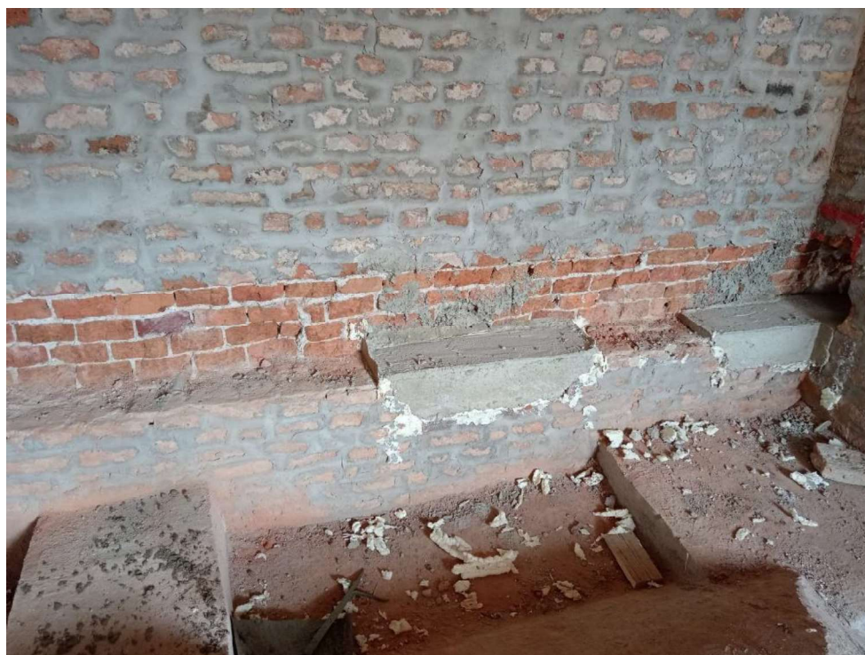
Slika 36 Štamanje zida za horizontalne serklaže i betonirani ležajevi za čelične nosače
