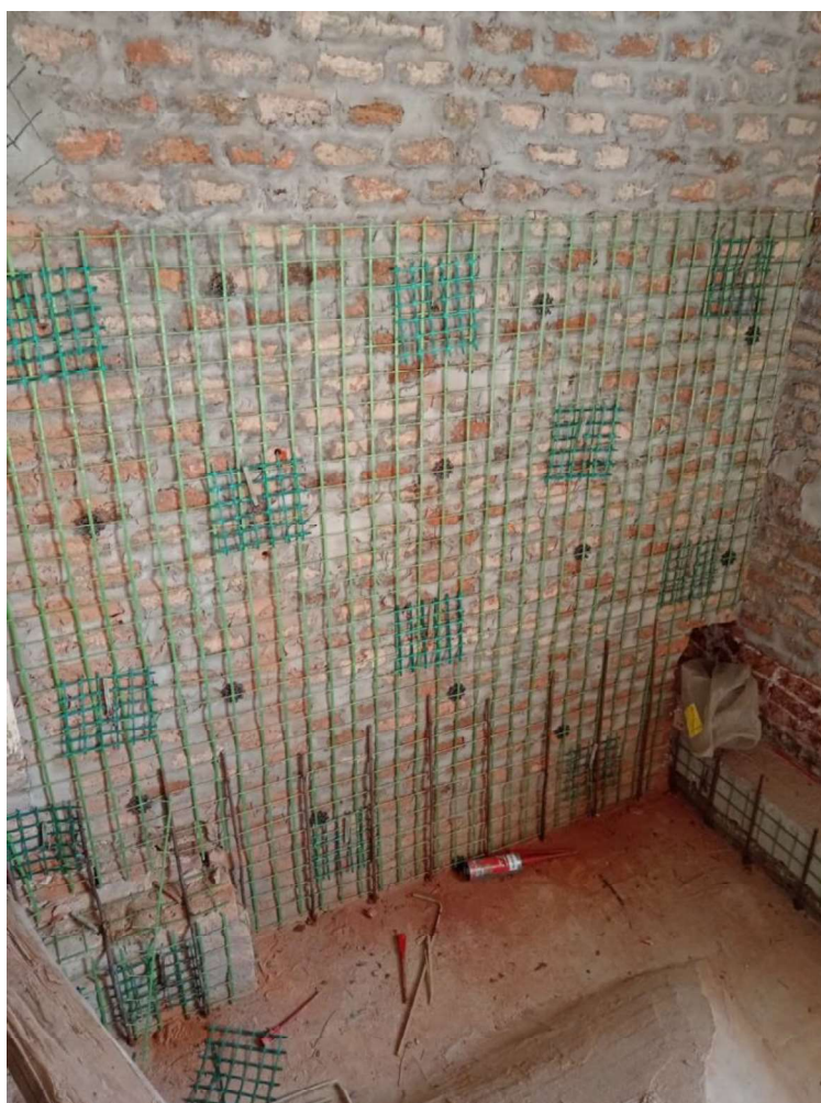
Slika 27 Postavljanje mreža i konektora na zidove
