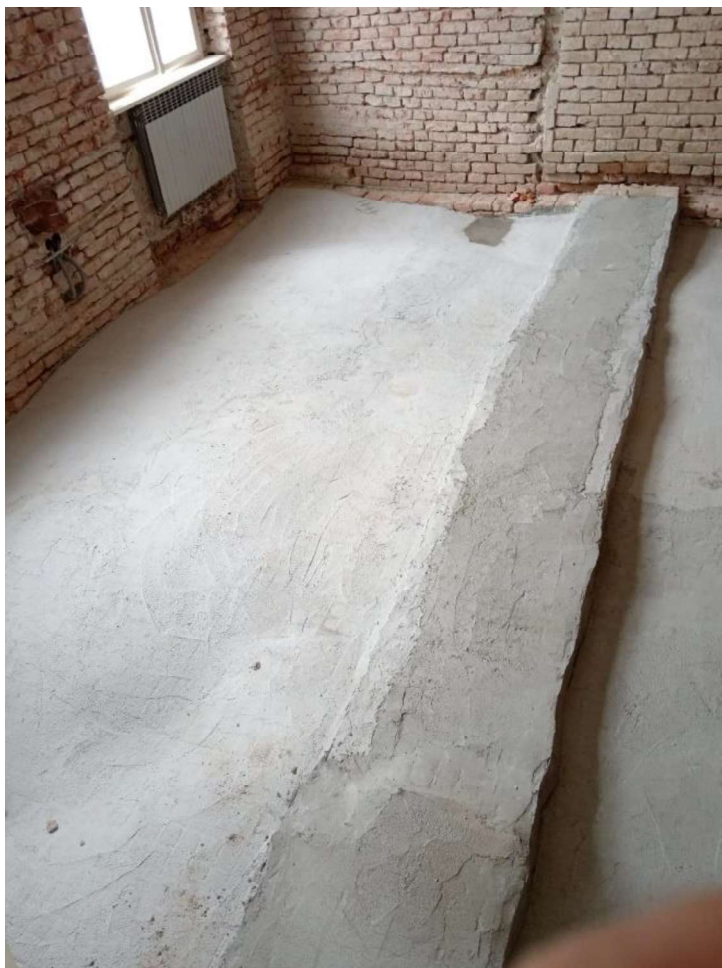
Slika 50 Završna obrada CRM sustava sa dodatnim ojačanjem
