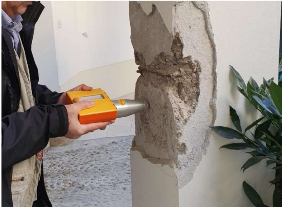
Slika 9 Ispitivanje kvalitete betona sklerometrom(Duvnjak,2021)
