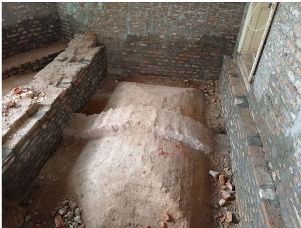
Slika 35 Uklanjanje slojeva šute na 2.katu
