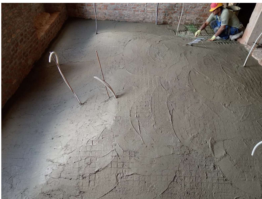
Slika 47 Završna obrada CRM sustava na svodovima
