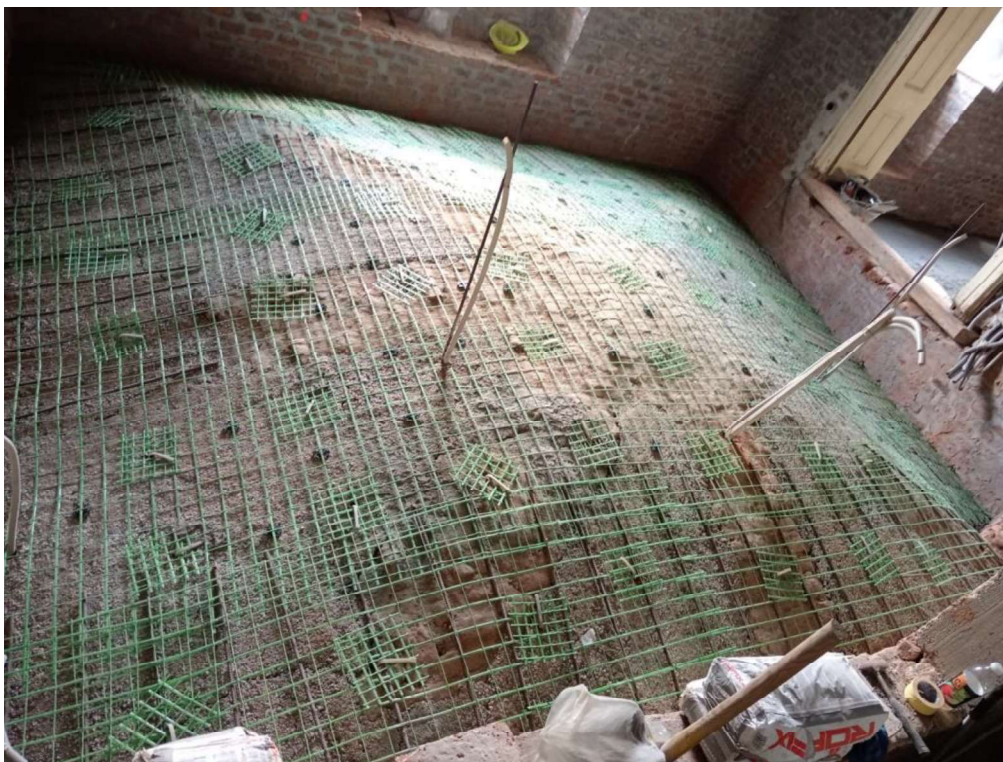
Slika 46 Izvedba CRM sustava na svodovima
