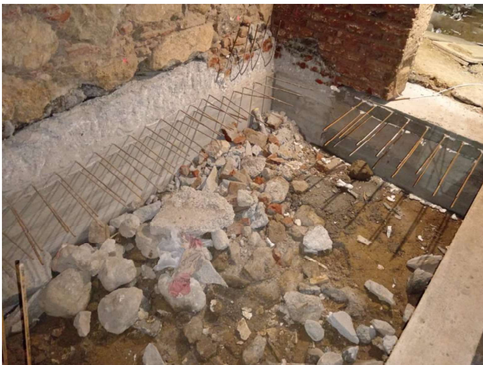
Slika 40 Završetak podbetoniranja
