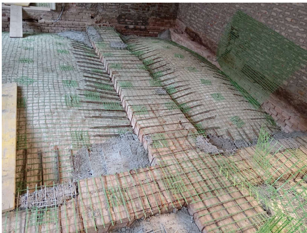
Slika 49 Prikaz rješenja CRM sustava sa dodatnim ojačanjem
