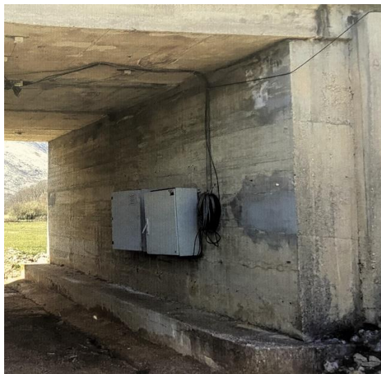
Slika 7 Instalirani prijenosni SiWIM uređaj na mostu [1]
