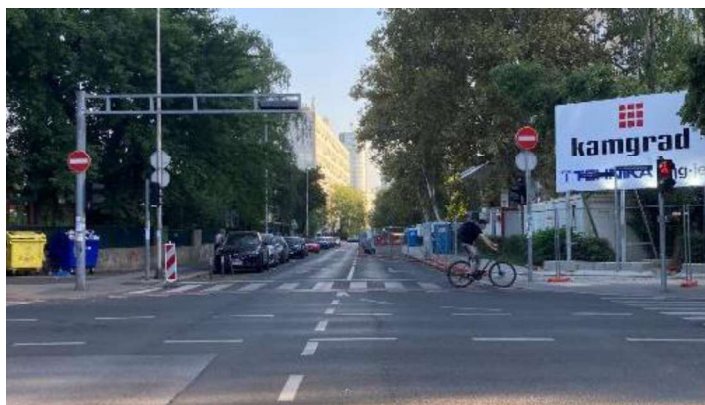
Slika 42. Južni privoz Kačićeve ulice na čvoru s Klaićevom ulicom (čvor 2)
