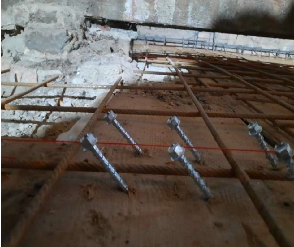
Slika 11 Postavljanje vijaka tlačne ploče
