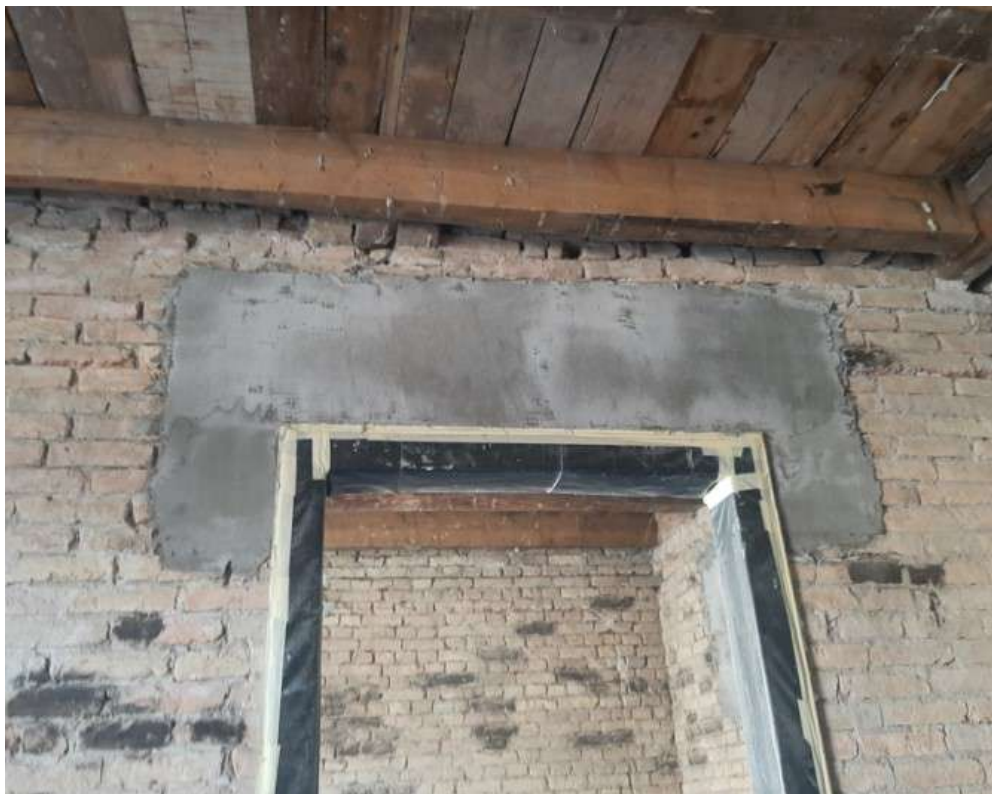
Slika 13 Saniranje nadvoja FRCM sustavom
