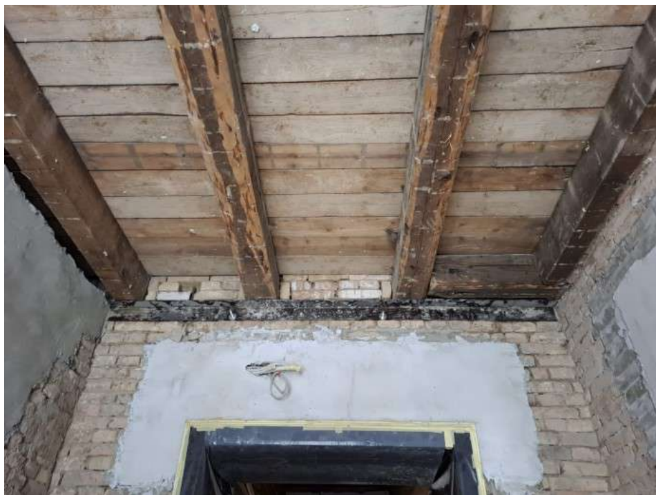
Slika 12 Postavljanje čeličnih zatega
