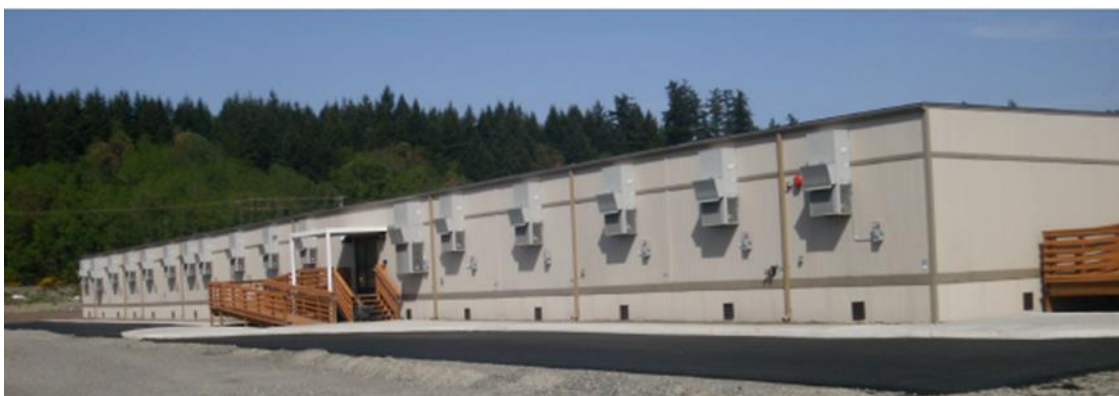
Slika 5 remjesta modularna konstrukcija (Izvor: Blumhorst, 2021)
