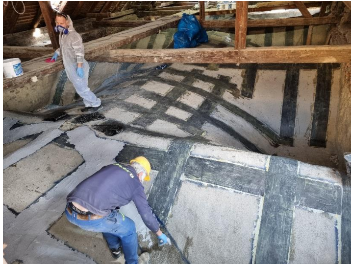
Slika 42. Ugradnja FRP traka na ekstradosu istočnog dijela crkve (Foretić, 2021)
