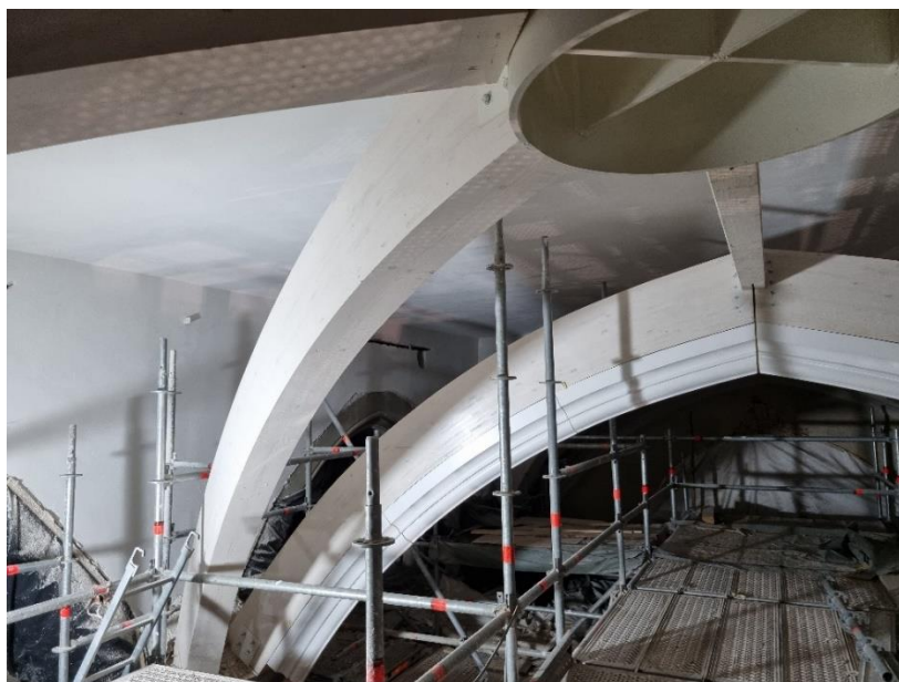
Slika 49. Detalj LLD nosača s pogledom iz unutrašnjosti crkve (Foretić, 2021)
