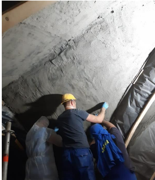
Slika 44. Ugradnja FRCM tkanina na intradosu svoda istočnog dijela crkve (Foretić, 2021)
