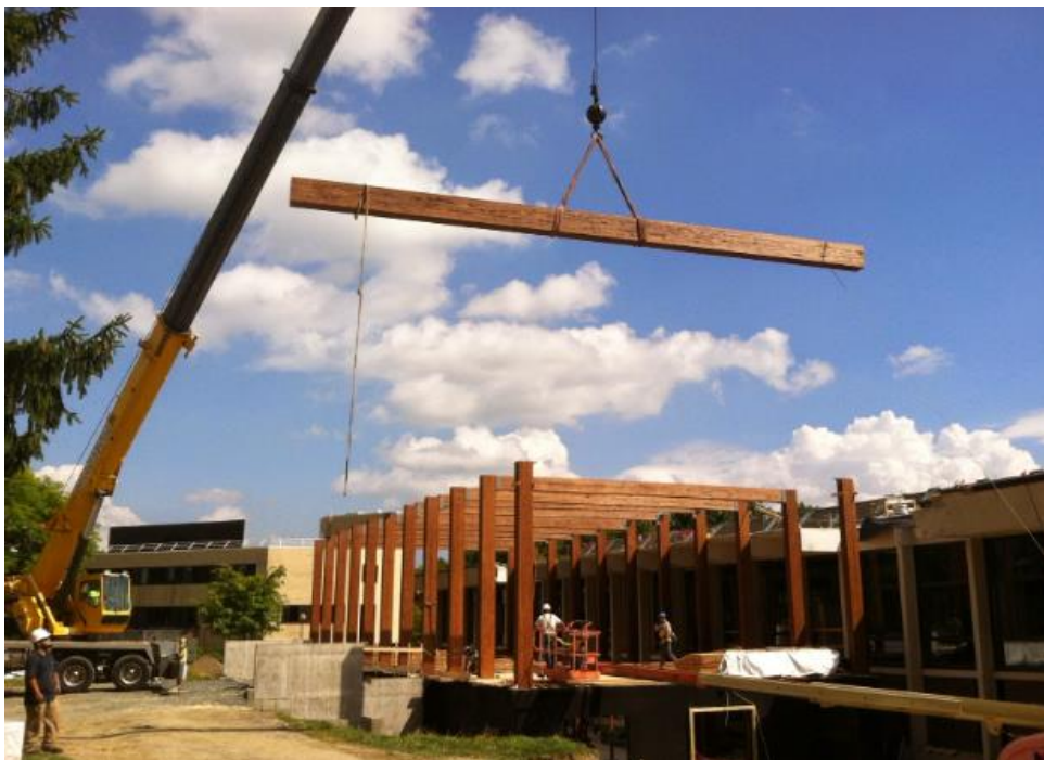
Slika 53. Primjer podizanja drvenih elemenata pomoću autodizalice
