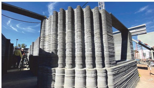
Slika 9. Trodimenzionalni ispis vanjskih i unutarnjih zidova, ostavljeno u izvornim slojevima [33]
