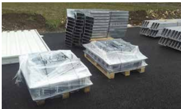
Slika 17. Skladištenje predgotovljenih elemenata na gradilištu
