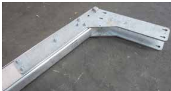
Slika 12. Priključci prečka - stup s čeličnim pločama [8]
