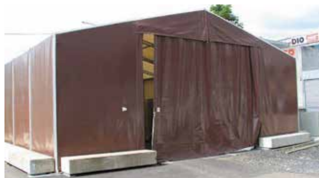
Slika 11. Osiguranje stabilnosti konstrukcije blokovima za sidrenje
