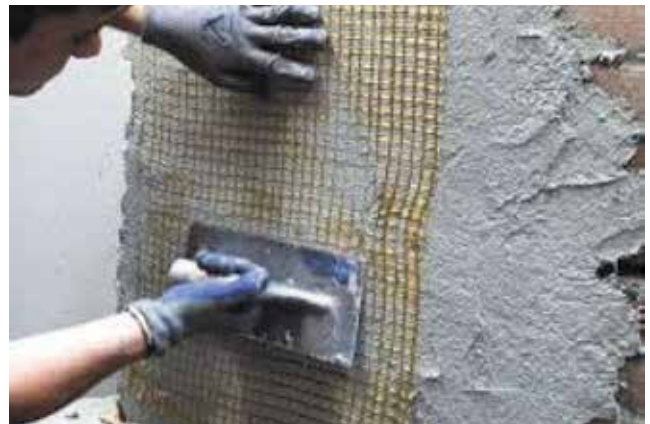
Slika 5. Nanošenje TRM-a [26]
