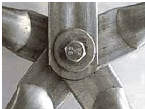
Slika 3. Neka rješenja čvorova čeličnih geodetskih kupola [5]
