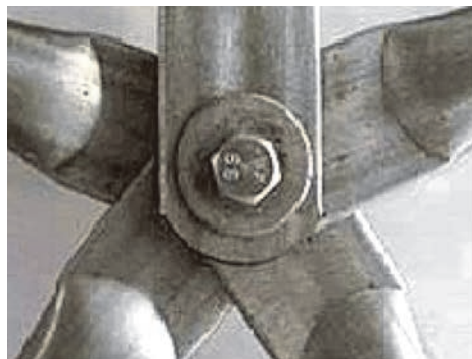
Slika 3. Neka rješenja čvorova čeličnih geodetskih kupola [5]
