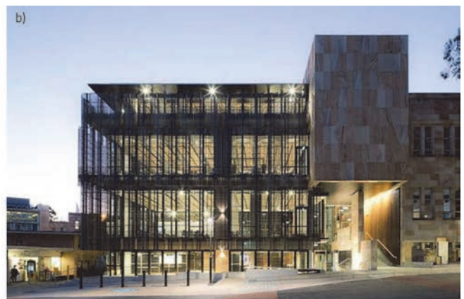
Slika 3. a) Tlačna čvrstoća OPC betona i alkalnoaktivirane mješavine letećeg pepela i zgre [31]; b) GCI trokatna zgrada Sveučilišta Queensland izvedena alkalnoaktiviranim betonom (geopolimer) [32]
