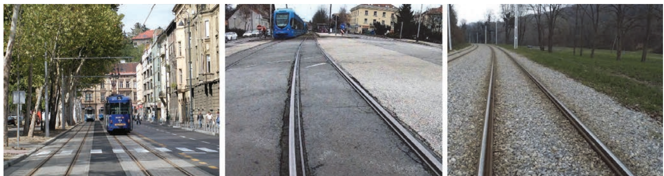
Slika 5. Zatvaranje kolosijeka na dionici 2 – AB ploče (lijevo), asfalt (u sredini), kameni agregat (desno)
