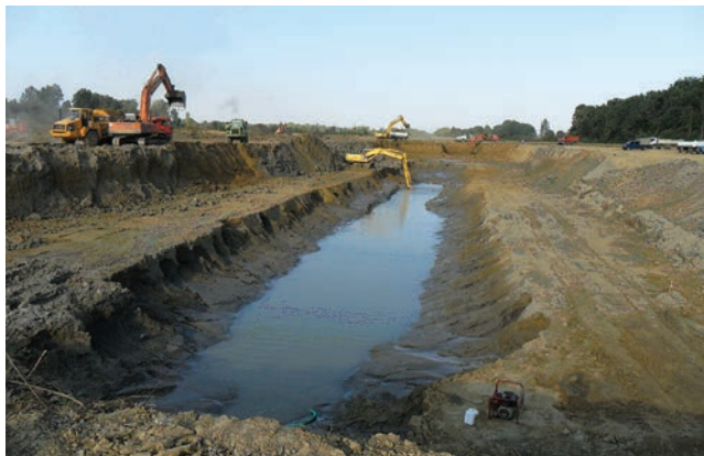
Slika 6. Izvedba radova na iskopu kanala [13]
