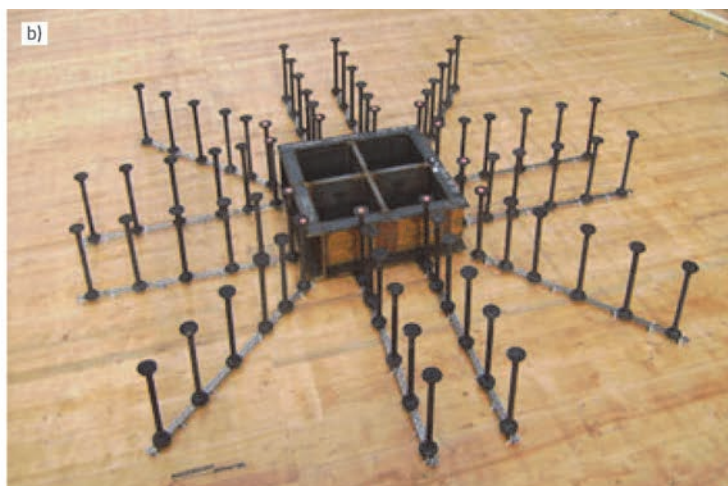
Slika 19. Konstrukcijski detalji – sustavi Geilinger Europilz: a) Geilinger-Europilz čelični roštilj; b) kombinacija čeličnog roštilja i moždanika
