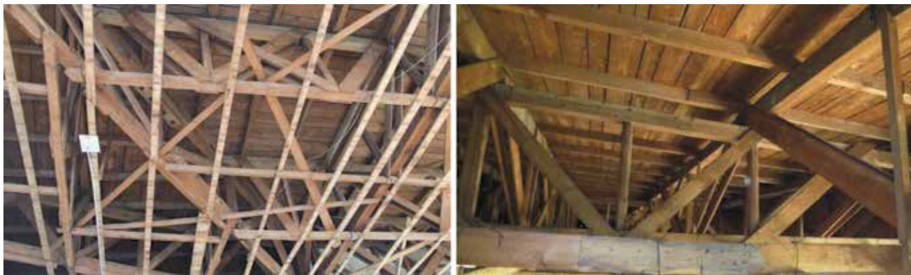
Slika 7. Pogled odozdo na južno krovnište Muzeja
