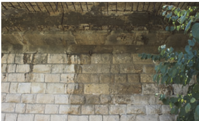
Slika 4. Izbočenje i promjena boje čeonog zida
